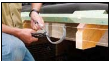
Beispiel der Anwendung der Doppelrichtschnur
